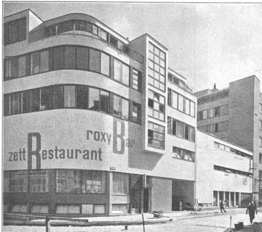
ZET-HAUS in Zürich Architekten: HUBACHER & STEIGER
