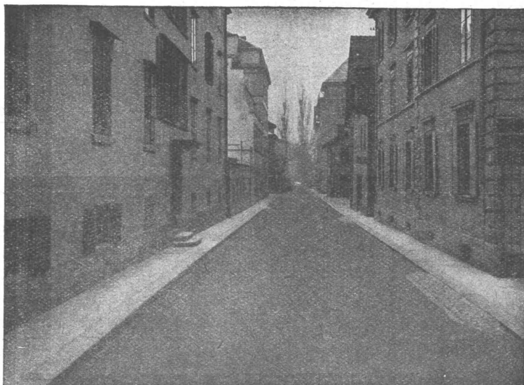
GLARNISCHSTRASSE ZÜRICH Walz-Asphalt: Topeka, 6 cm stark
