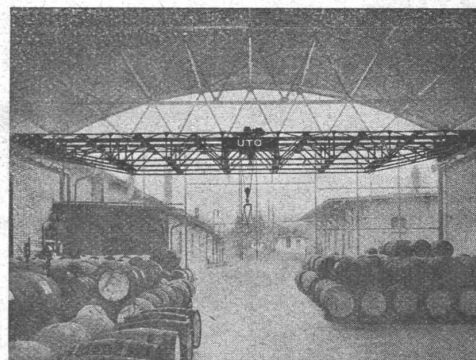
3 Motoren-Laufkran für Lagerschuppen.
