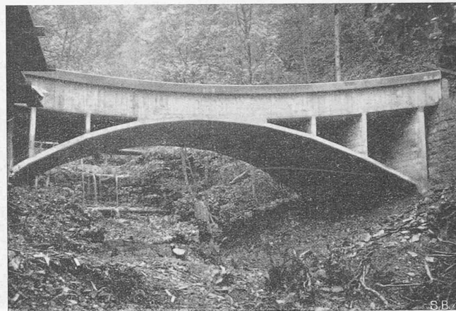
Abb. 3 und 4. Fertige Bohlbachbrücke, Stützweite 14,40 m, Strassenaxe R = 15 m, Steigung 80/0.
