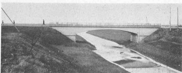
Abb. 5 und 6. Ein Hauptkanal der Bonifica Parmigiana-Moglia.
