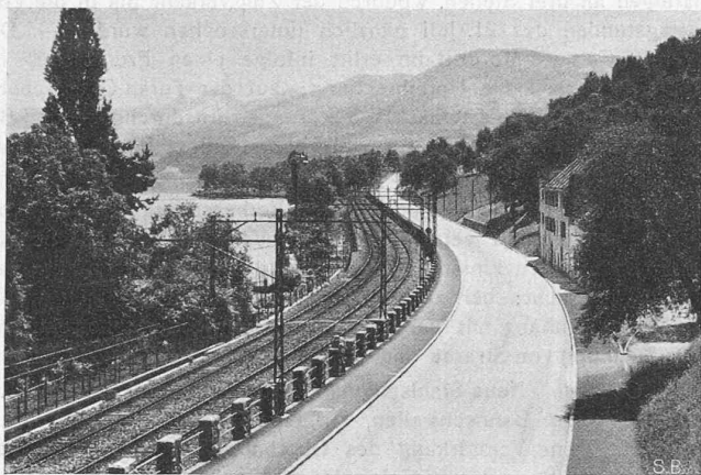
Abb. 8. Linksufrige Zürichseestrasse, neben der Hauptbahn zwischen Wädenswil und Richterswil. Breiten 3,0 + 8,0 + 2,5 m.
