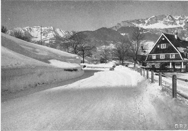
Abb. 13. Kulmination bei Rütegg; Fahrbahn 7 bis 8 m breit.
