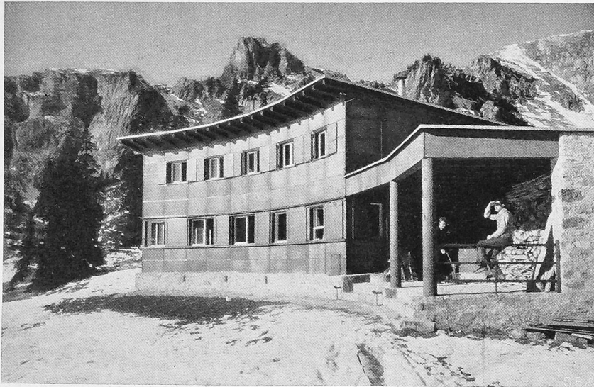
Abb. 2. Ortstockhaus aus Südosten.
