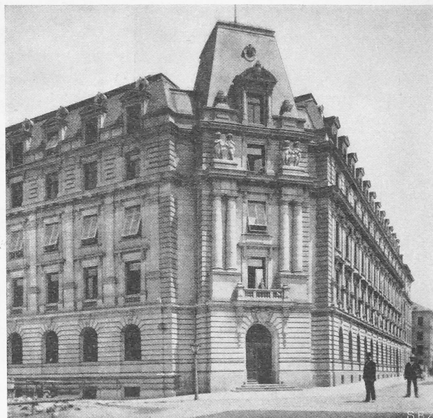
Abb. 1. Das PTT-Verwaltungsgebäude in Bern, erbaut 1892, vor dem Brande.
