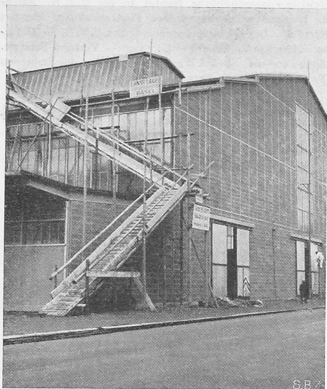
Abb. 7. Stirnseite Sperrstrasse der fertigen Halle VI.
