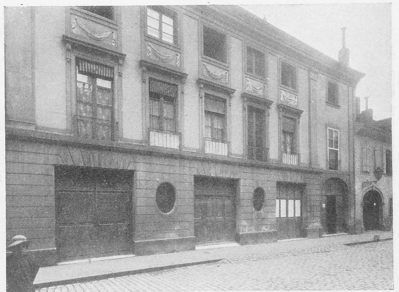
Abb. 8. Haus Steiner, Rue du Four in Yverdon.
