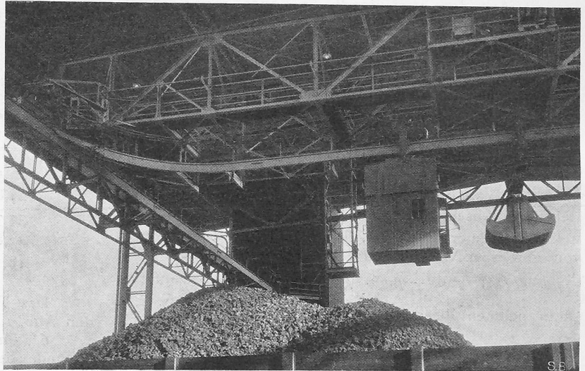
Abb. 3. Teilansicht des Laufkrans.
