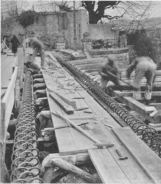
Abb. 3. Verstärkung der Jägerbrücke über die Bahnlinie Biel-Sonceboz.
