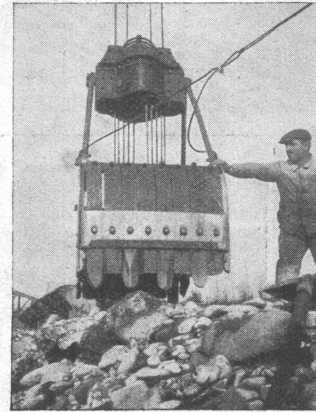
Verwendung von Stahldrahtseilen in Greifbaggern.
