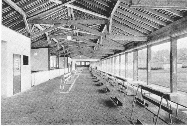
Abb. 3. Innenansicht des neuen Luzerner Schiessstandes.
