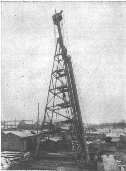
Verwendung von Stahldrahtseilen in Rammern.
