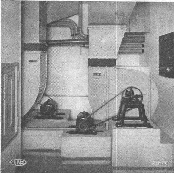
Ventilatorenraum einer größeren Lüftungsanlage. Alle beweglichen Teile und die Luftkanäle sind leicht zugänglich. Gehäuseventilatoren mit hohem Wirkungsgrad und geräuschlosem Gang. Segeltuchstützen am Ein- und Austritt des Ventilators, sowie Korkisolierung der Fundamente zur Verhütung von Schwingungen und Erschütterungen. Luftdicht schließende Kontrolltüre ermöglicht bequemen Zugang zu den Staubfiltern.
