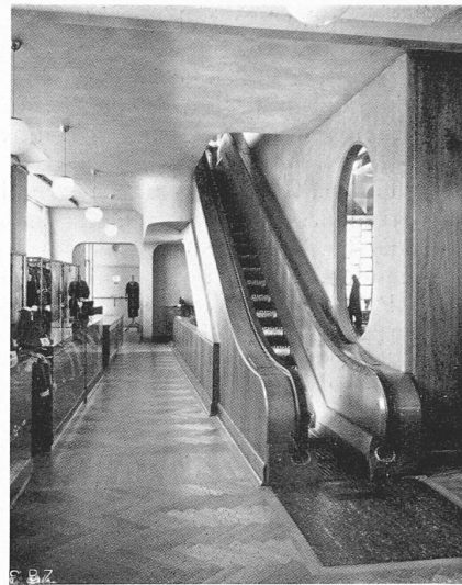
Abb. 21. Rolltreppe neben der Halle.
