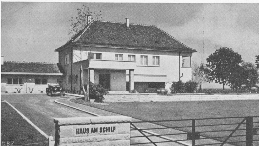
Abb. 4. Ansicht aus Westen, von der Strassenzufahrt aus gesehen.
