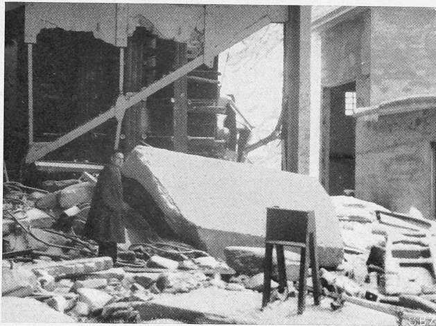
Abb. 2. Etwa 12 t schweres Stück der Betonabdeckung des geplatzten Rohres, 45 m weit in die Transformatorzellen III geschleudert.
