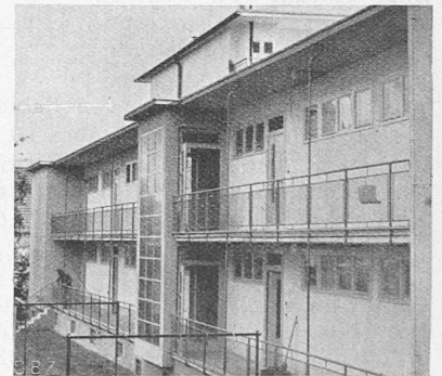
Abb. 4. Die Bergseite mit den Wohnungszugängen.
