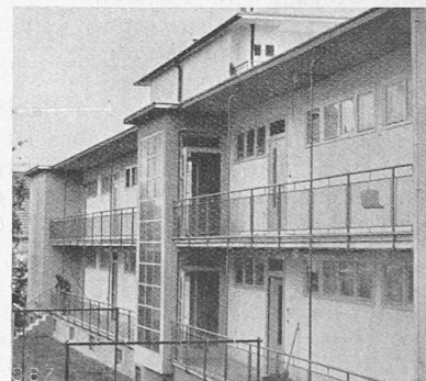
Abb. 4. Die Bergseite mit den Wohnungszugängen.
