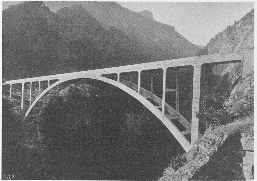
Abb. 1. Die Trientbrücke bei Gueuroz oberhalb Vernayaz, Kt. Wallis. — Ing. A. Sarrasin, Lausanne.
