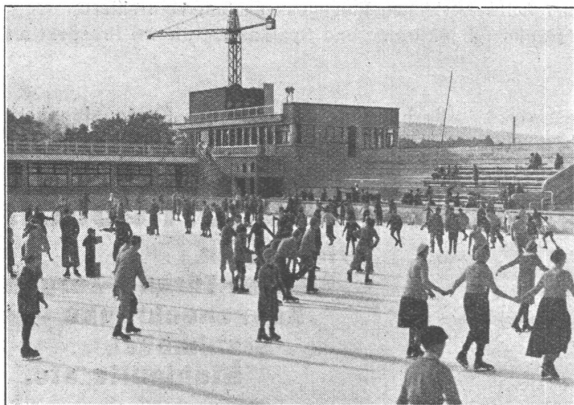
Kunsteisbahn in Bern, ca. 4000 m 2 Kork- und mehrlagige Pappe-Isolierung.
