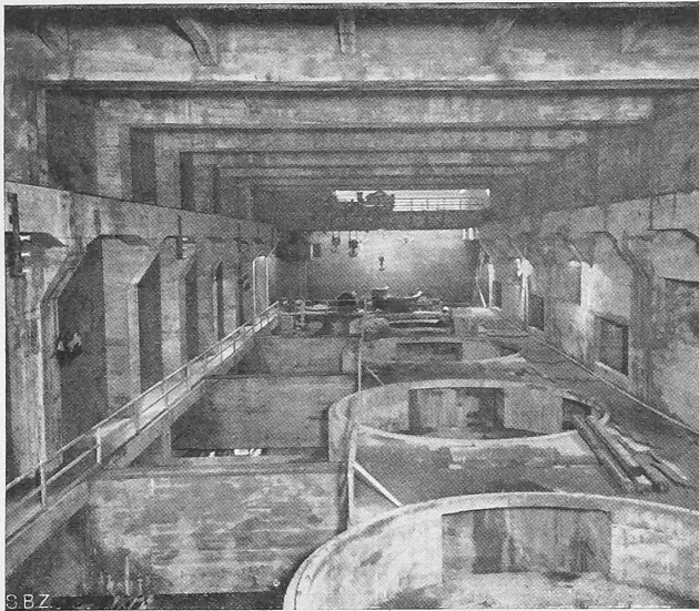
Abb. 35. Der Generatorensaal im Rohbau (rechts Seeseite).
