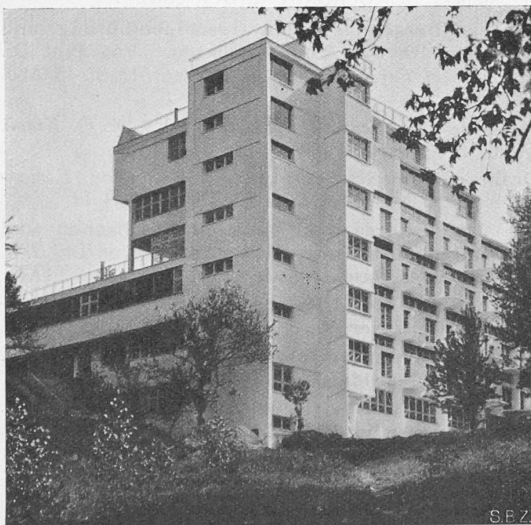
Abb. 7. Westecke des Spitals (aus Südwest).
