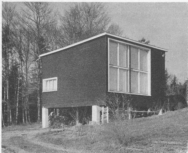
Abb. 1. Atelierhaus Leisinger, Wetzwil. — Arch. W. Boesiger, Zürich.
