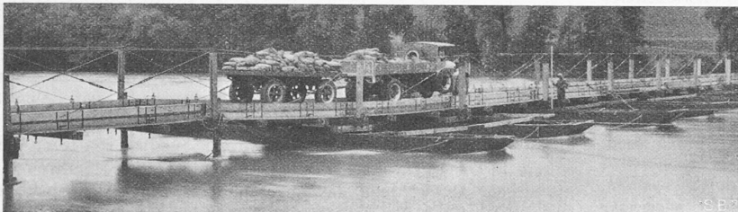
Abb. 3. Schwere Brücke, mit Lastzug von 12 + 7 t. — Verschiedene Versuchs-Pontons.
