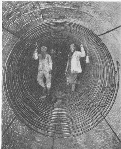
Abb. 15. Armierung der Gunitverkleidung im Sernfistollen bei WP V. (26. Februar 1931.)
