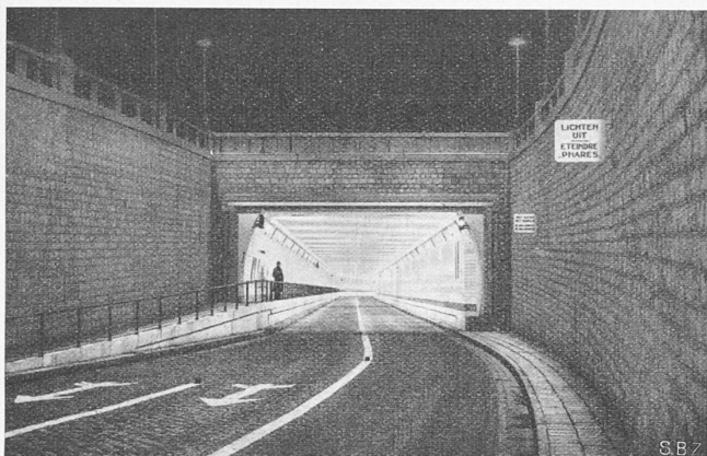
Abb. 5. Einfahrt von Antwerpen in den Scheldetunnel.
