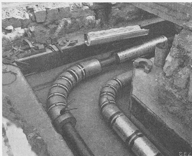
Abb. 6. Geöffneter Heizkanal bei der Durchführung der Isolierarbeiten.
