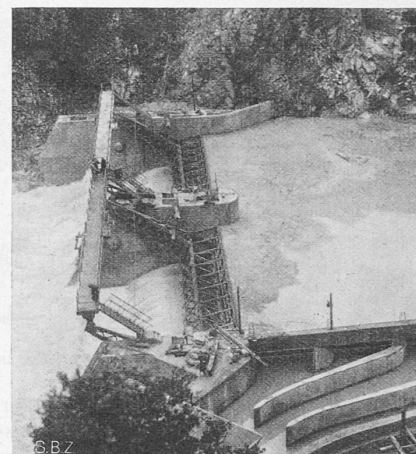
Abb. 10 und 11. Automatisches Wehr im Fiume Nete. Links Ueberlauf der Steuerorgane in Funktion.
