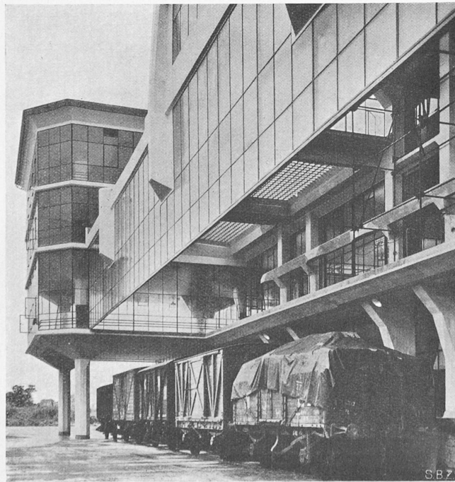
Abb. 30. Boots Chemische Fabrik bei Nottingham. Arch. Sir Owen Williams.
