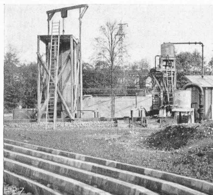
Abb. 2. Gesamtbild der Versuchsanlage.
