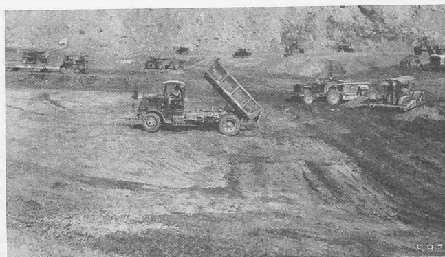
Abb. 9. Mohawk-Damm, Bauzustand im November 1935.
