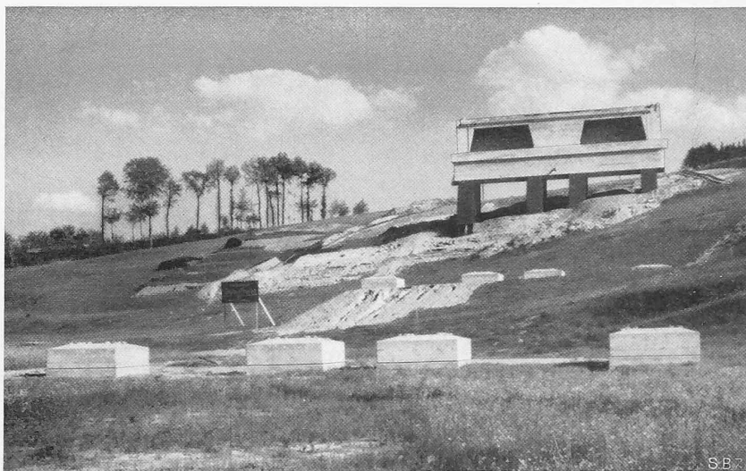
Abb. 26. Talbrücke bei Tautendorf (bei Gera). Widerlager und Pfeilersockel für durchlaufende Stahlblechträger mit Leichtfahrbahn auf Stahlpendelrahmen.
