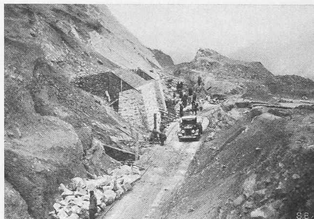
Abb. 5. Einschnitt bei Km. 190,5.
