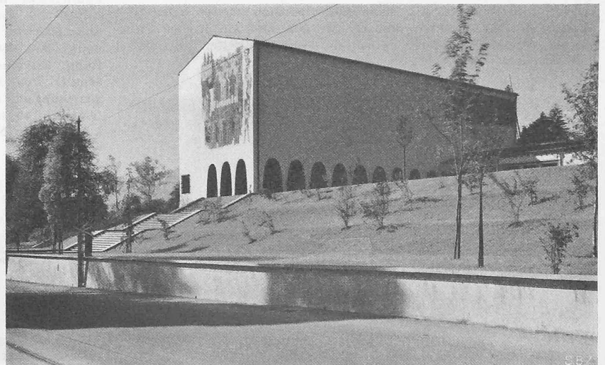
Abb. 2. Hauptansicht aus Südost, von der Bahnhofstrasse aus.
