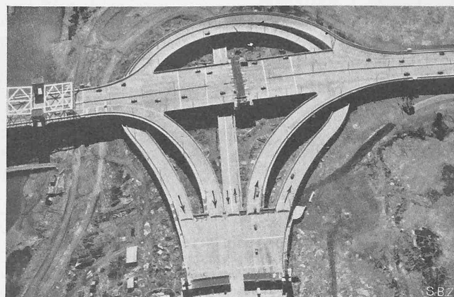
Abb. 7. Das grosse Strassenanschluss-Bauwerk auf Randall's Island.
