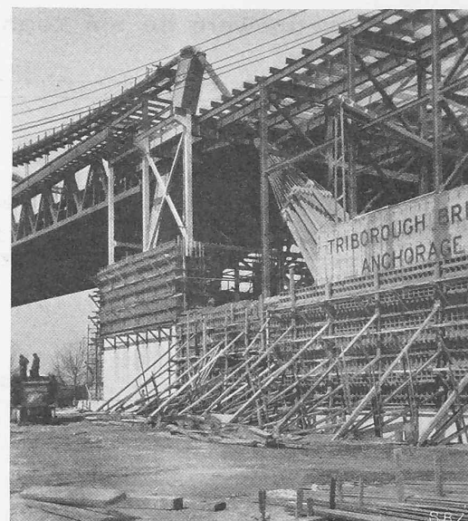
Abb. 4. Verankerung der Triborough Bridge auf der Seite von Queens. — Abb. 4 und 6 phot. H. Krenn.
