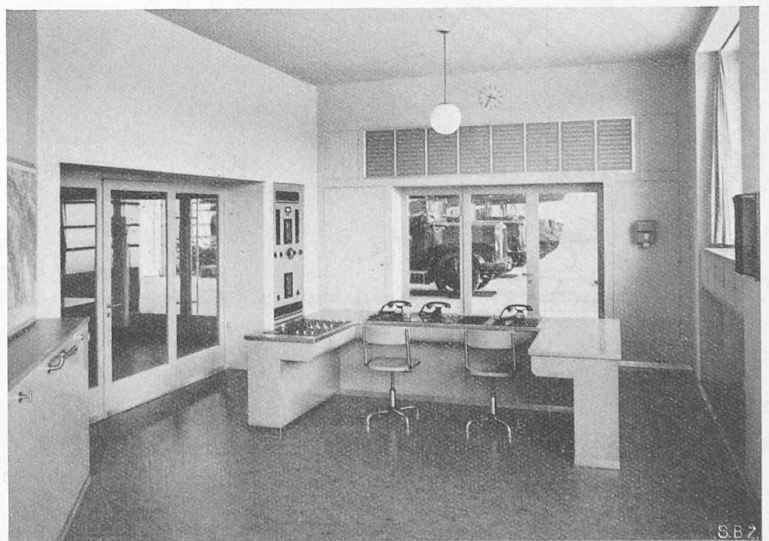
Abb. 13. Feuermelderaum im Erdgeschoss mit Uebersicht der Gerätehalle
