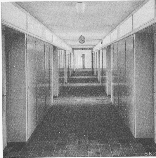
Abb. 9. Korridor zwischen den Schlafräumen
