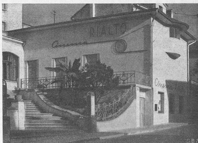
Abb. 12. Der umgebaute Kino Rialto in Muralto Rechts oben Projektionskabine, im Kreis Ventilationsöffnung
