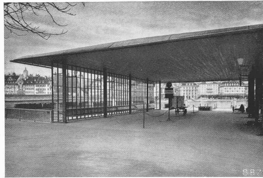
Die neue Dampfschiffllände am Bahnhofplatz in Luzern, Arch. ARMIN MEILI, Luzern-Zürich.
