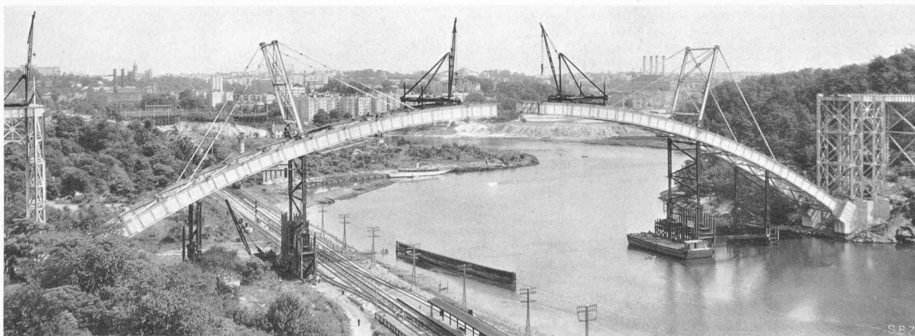
Abb. 3. Montage der Bogenträger im Freivorbau, Juli 1936; Blick gegen Südosten (Manhattan)
