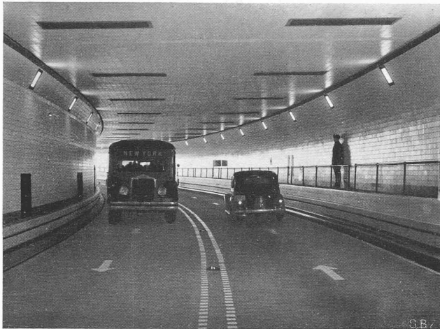
Abb. 8. Der Lincoln-Tunnel, vorläufig in Zweibahnbetrieb
