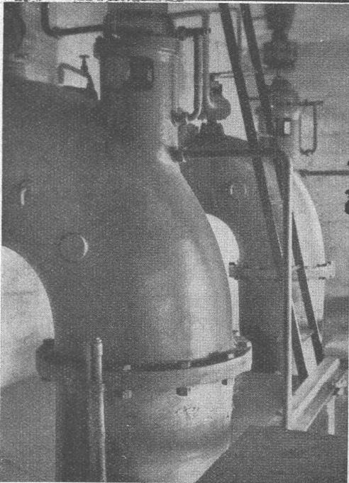
Vertikal-Propellerpumpe 30 000 lit/min
