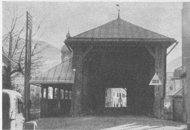
Abb. 2. Durchblick mit flussabwärts angebautem Gehsteg
