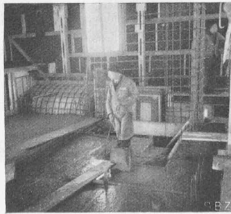
Abb. 12. Betonieren der Decke über I. St., l. hinten Thermometer-Nische
