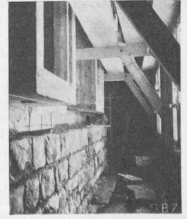
Abb. 14. Betonierte Fenster- und Vormauerung
