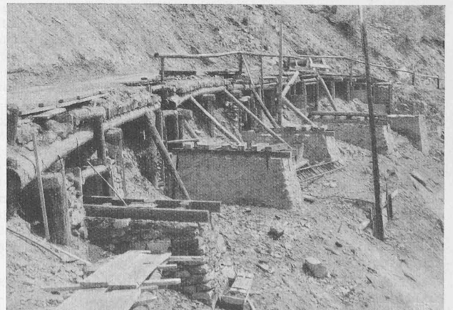
Abb. 11. Neue Fundamente des Lehnenviadukts Magnacun
