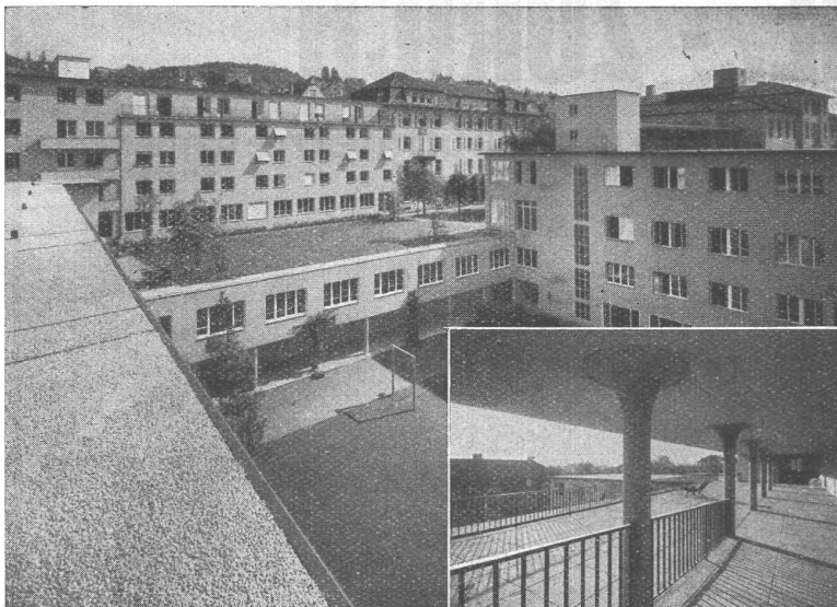
Schweiz. Pflegerinnenschule Zürich Architekten: Gebr. Pfister, Zürich
