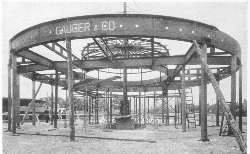
Abb. 3. Die mittleren Ringstützen, Bauzustand am 4. Oktober 1937
