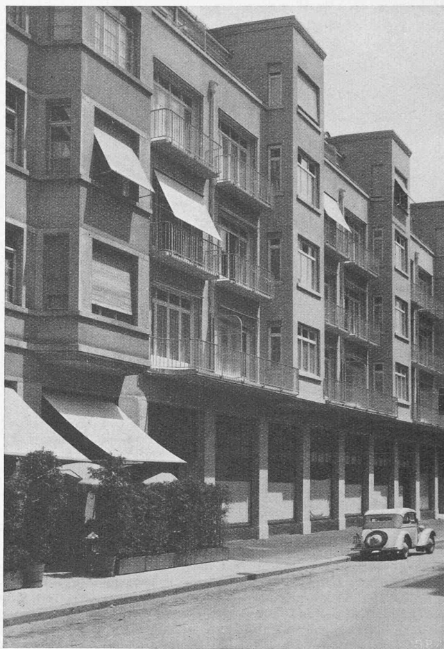
Abb. 1. Appartementhaus «Muralto» Zürich. Arch. H. WEIDELI
