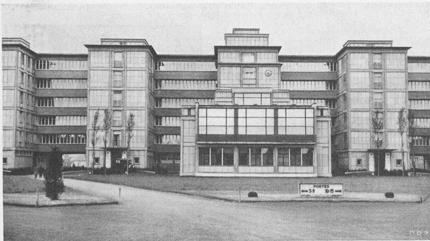
Abb. 6. Nordfront des Hauptbaues, vom Haupteingang aus
